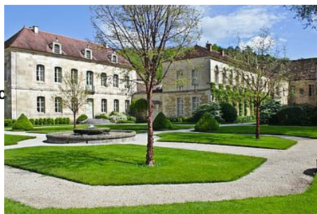
Vallon de Fontenay
